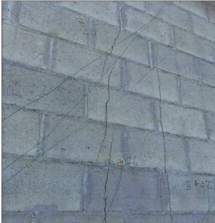
Detail trhlin na NS
