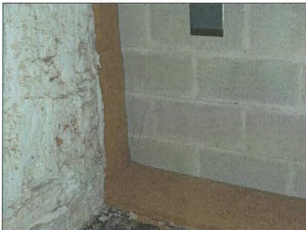
Detail trhlin v dolních rozích na OS
